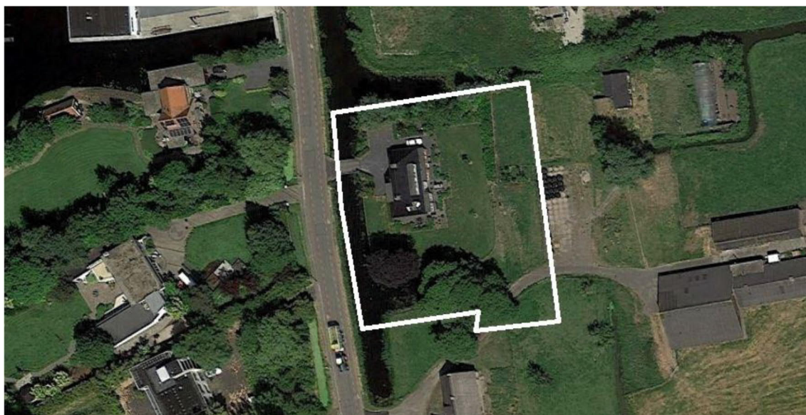
Afbeelding 2.7: Huidige situatie perceel Herenweg 12 (bron: GoogleMaps).
