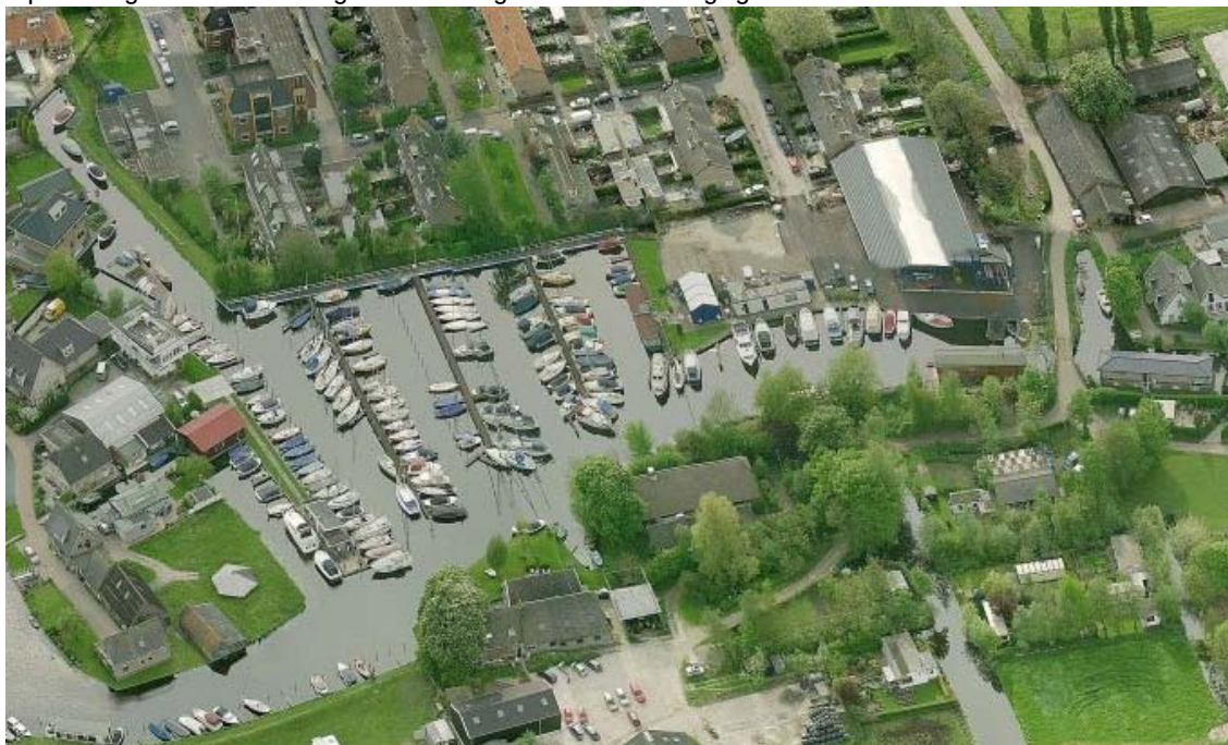
Figuur 1.2 Bestaande situatie
