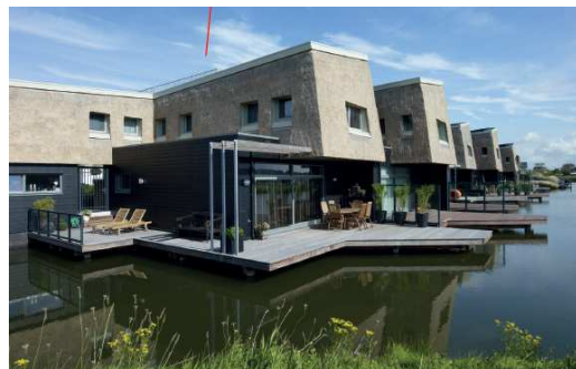
referentie terraswoningen aan het water
