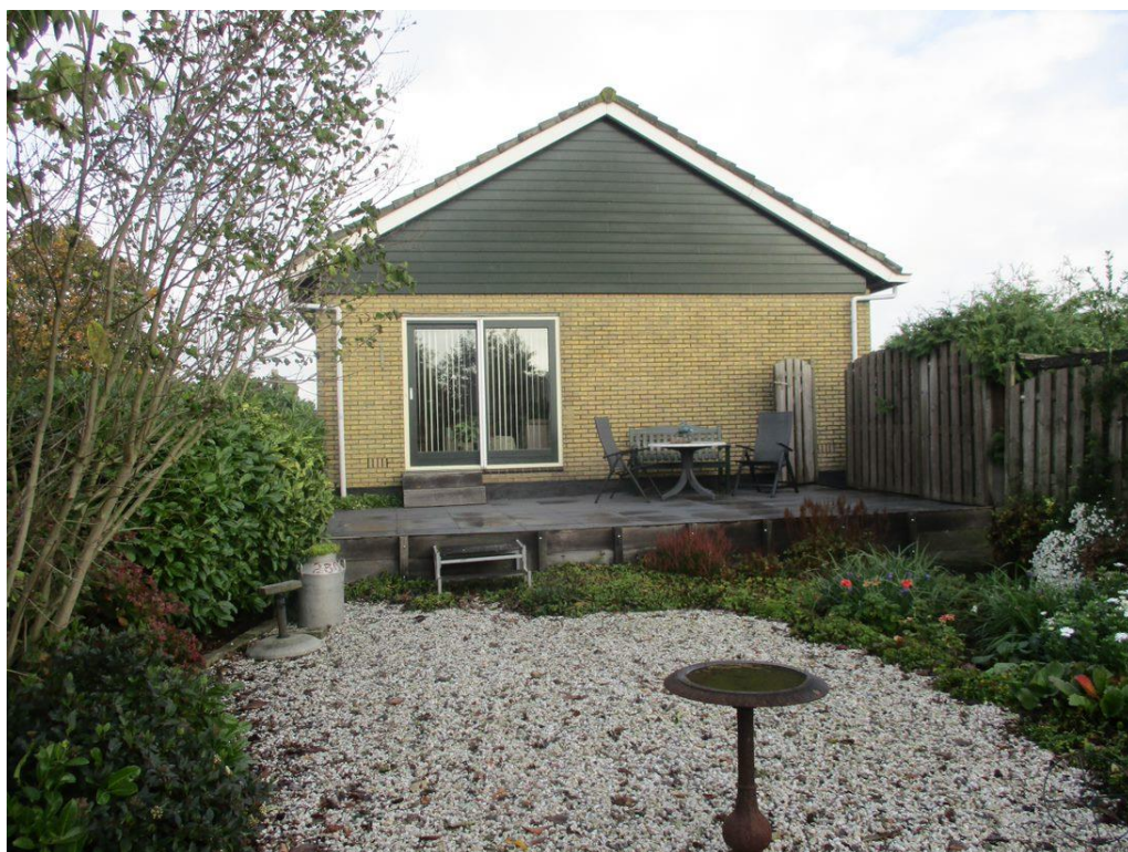
Figuur 2 De zuidzijde van de woning met achtertuin.
