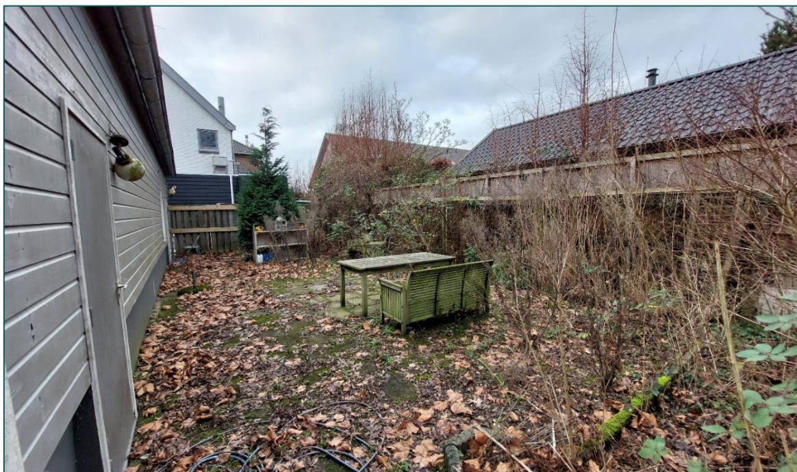
Figuur 2 Impressie van de tuin en gevel aan de noordzijde van het gebouw met zicht op de schutting die de erfgrans afbakt. De weergegeven groenstructuren komen te vervallen bij de sloop/nieuwbouw.
