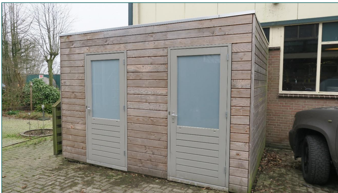
Figuur 3 De berging is opgebouwd uit houten schroten en heeft een plat dak.
