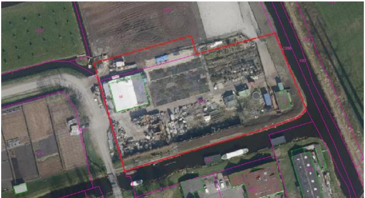
Afbeelding 1: Plangebied (rode kader) en huidige situatie. De loods linksboven (groene kader) wordt gesloopt en een iets grotere loods komt daarvoor in de plaats. Op de rest van het plangebied vinden geen ruimtelijke ontwikkelingen plaats.
