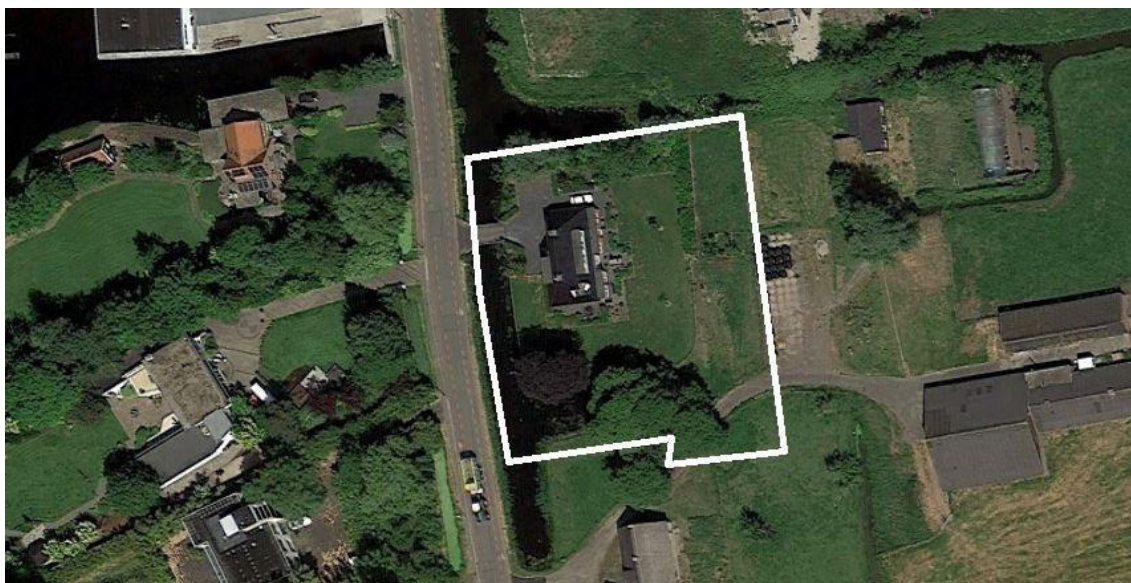
Afbeelding 2.7: Huidige situatie perceel Herenweg 12 (bron: GoogleMaps).
