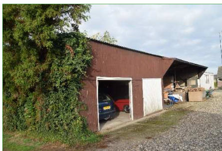
Gebouw 4: Kapschuur en garage.
