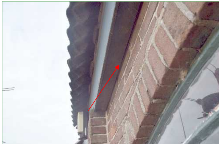
Kieren in gebouw 1 kunnen toegang geven tot voor vleermuizen geschikte ruimten.
