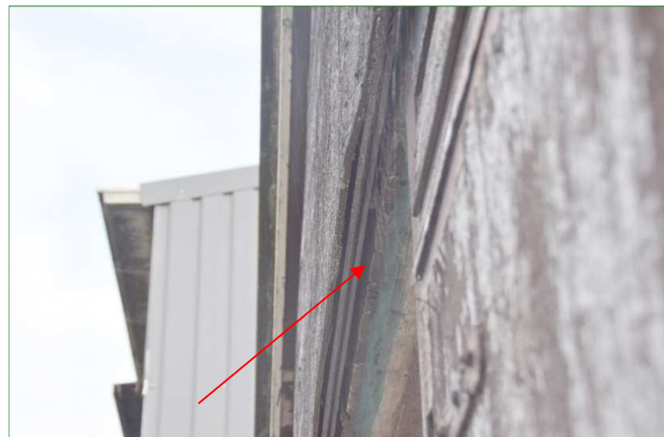
Kier in gebouw 3 kan in gebruik zijn door vleermuizen.
