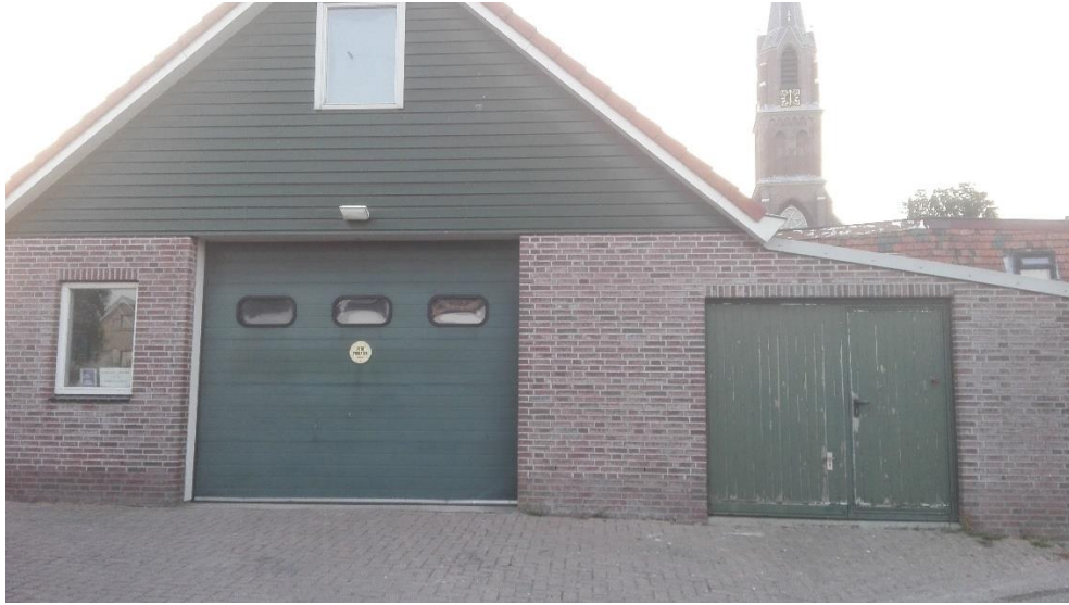
Figuur 1 De schuur die gesloopt zal worden ten behoeve van de vrijstaande woningen die worden gebouwd is opgebouwd uit steense muren en houten rabatdelen aan de kopse kant. De zijkanten van de schuur zijn tevens opgetrokken uit steense muren.
