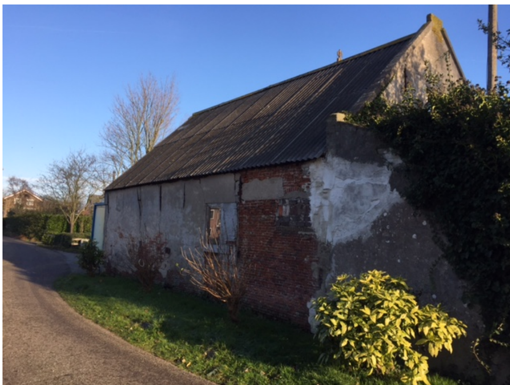
Figuur 2 Alle bebouwing wordt gesloopt ten behoeve van 5 nieuwe woningen. De bijgebouwen bestaan veelal uit oude kleine schuurtjes met steense muren en ongeïsoleerde daken.
