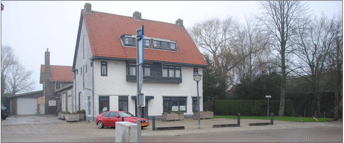
Afbeelding 2. Het westelijk deel van het plangebied. Foto vanaf de Dr. Stapenséastraat richting noorden.
