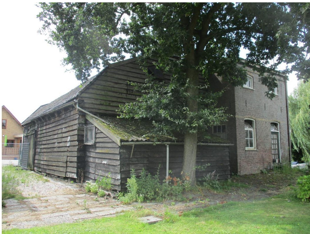
Figuur 1 Graanmaalderij met aangebouwde houten schuur. Het hoofdgebouw is metselt zonder spouw met een plat dak. De aangebouwde schuur beschikt over houten muren en een pannendak.
