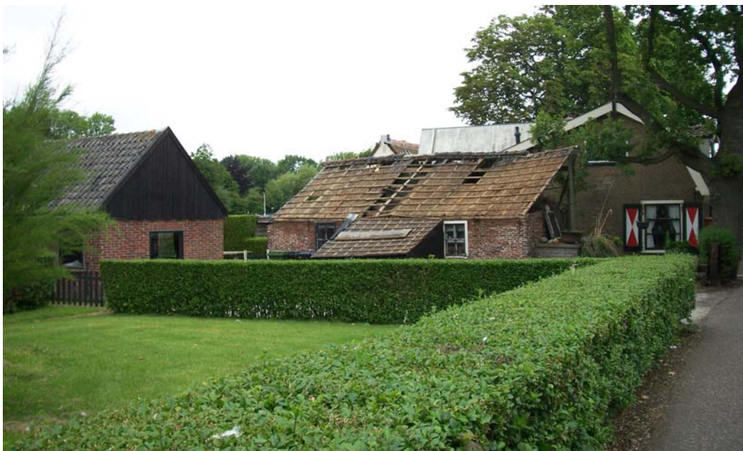
Bestaande (te slopen) opstallen in het plangebied met op de achtergrond het voormalige postkantoor.
