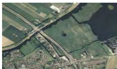
aanloop talud tbv oversteek Ringvaart
