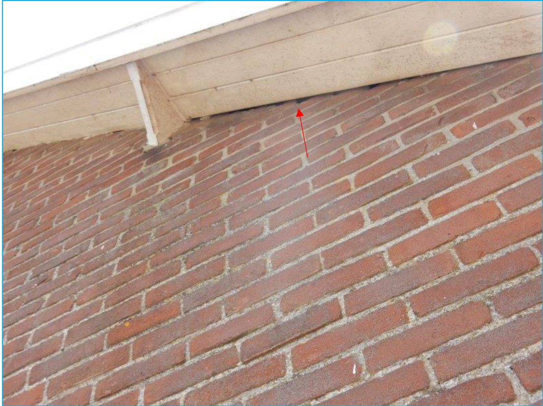
Foto: Dergelijke kleine openingen zijn vaak genoeg om bij de ruimte tussen de dakpannen en het isolatiemateriaal en/of in een eventueel aanwezige spouw te komen.
