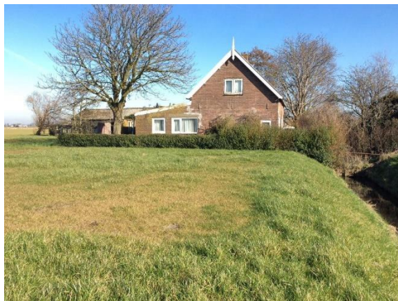
Fotonummer 6: Zuidzijde onderzoekslocatie.
