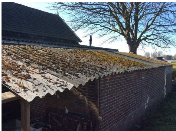
Foto 1: Schuur op achterterrein ter plaatse van de onderzoekslocatie.
