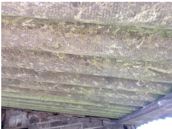
Fotonummer 1: Dak schuur achterterrein
