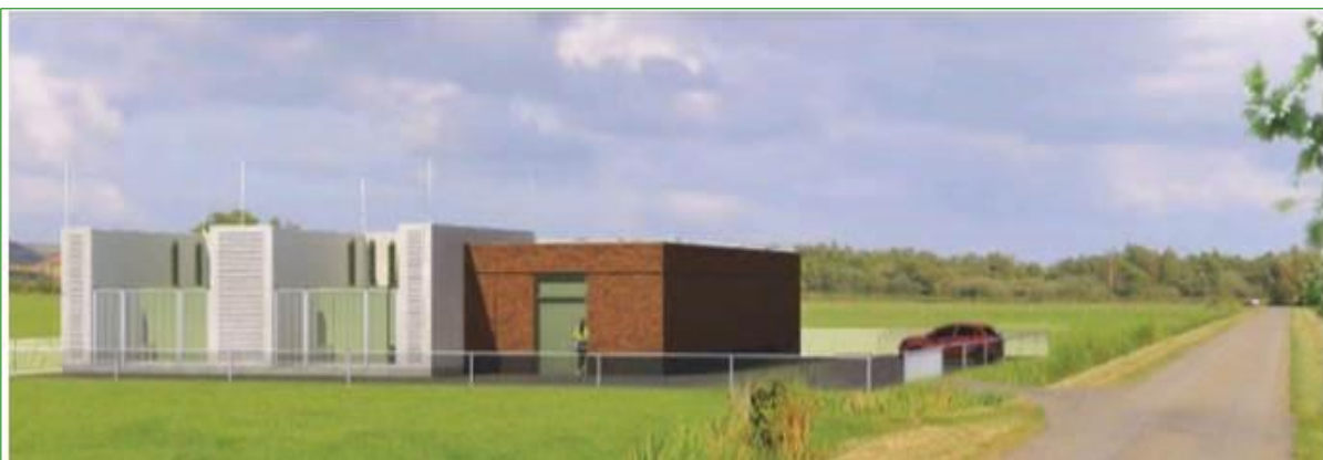
Figuur 2. Algemene impressie van een standaard transformatorstation.
