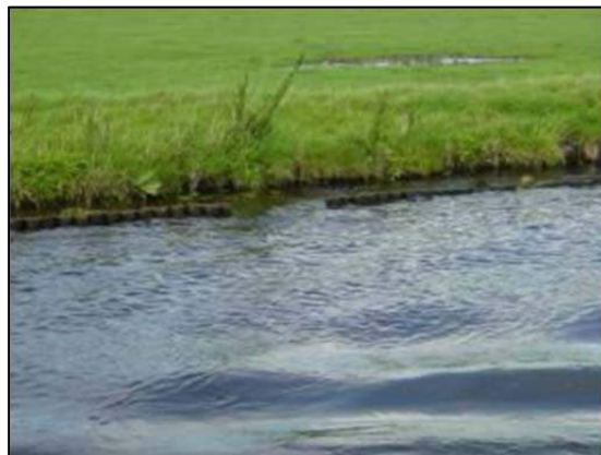
Figuur 5.7b. Golfbestendige oever met vooroeververdediging (HHvR, 2010).
