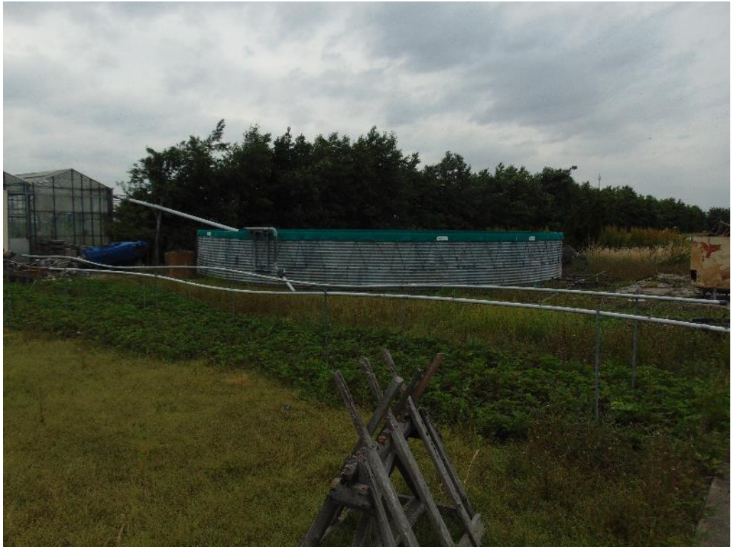
Figuur 3 De bestaande watersilo t.b.v. de sierteeltkwekerij wordt gesaneerd.
