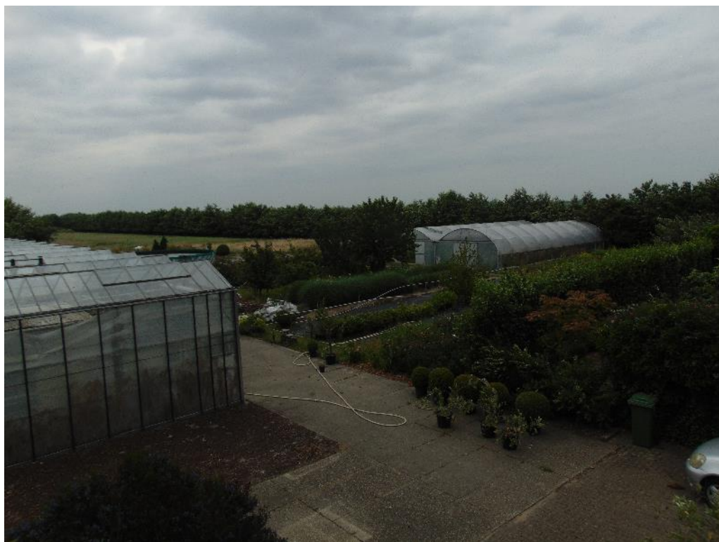
Figuur 2 De te saneren kas (links) en tunnelkas (rechts).
